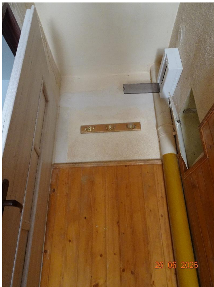
Fot. 3. Klatka schodowa lokalu nr 3,4.
