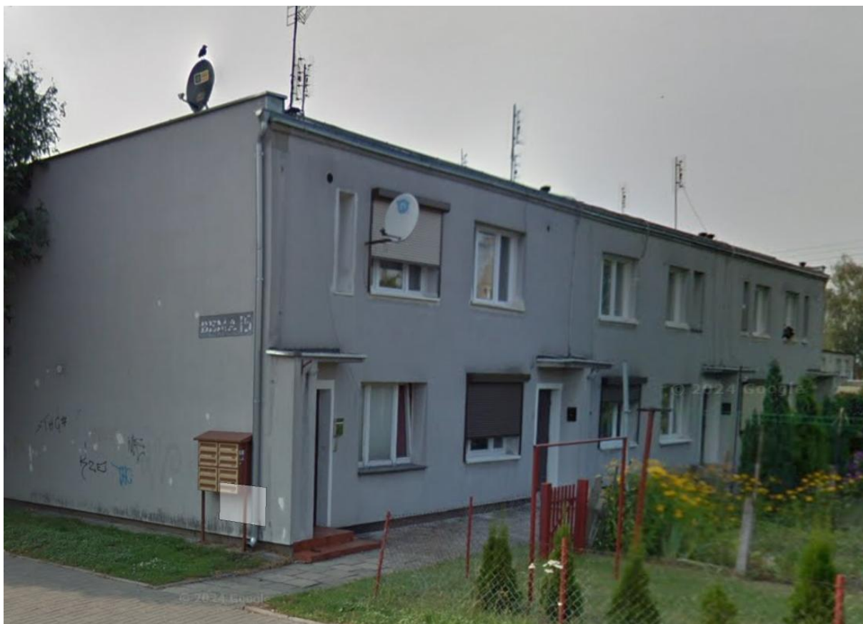
Fot. 1. Widok ogólny budynku.
