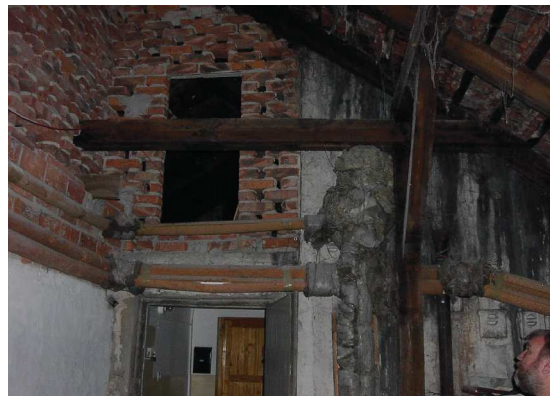
Widok wejścia na strych od strony północnej
