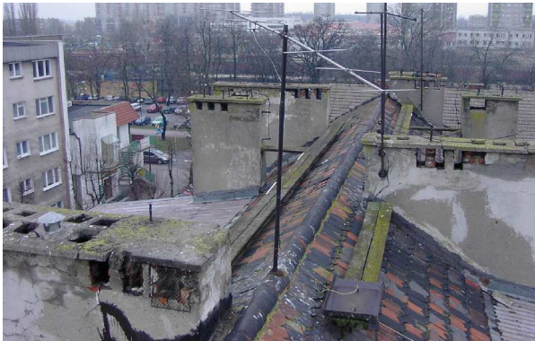
Widok dachu w kier. północnym
