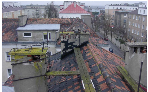
Widok dachu w kier. południowym
